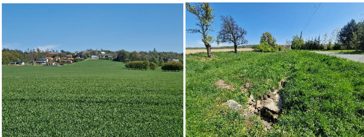
Obr. č. 15: Fotodokumentace kritického bodu KB04
