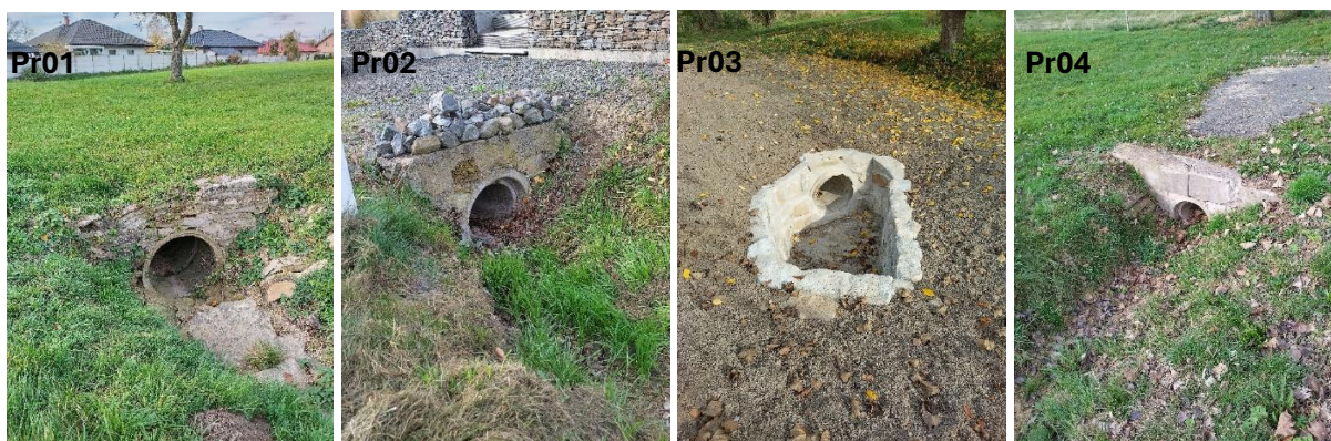
Obr. č. 30: Zkoumané propustky
